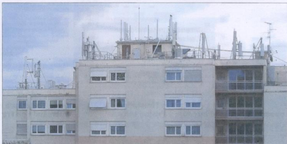
Les riverains s'inquiètent de plus en plus de la multiplication des antennes relais et de leurs effets sur la santé, comme ici sur le toit d'une résidence pour personnes âgées à Strasbourg.
